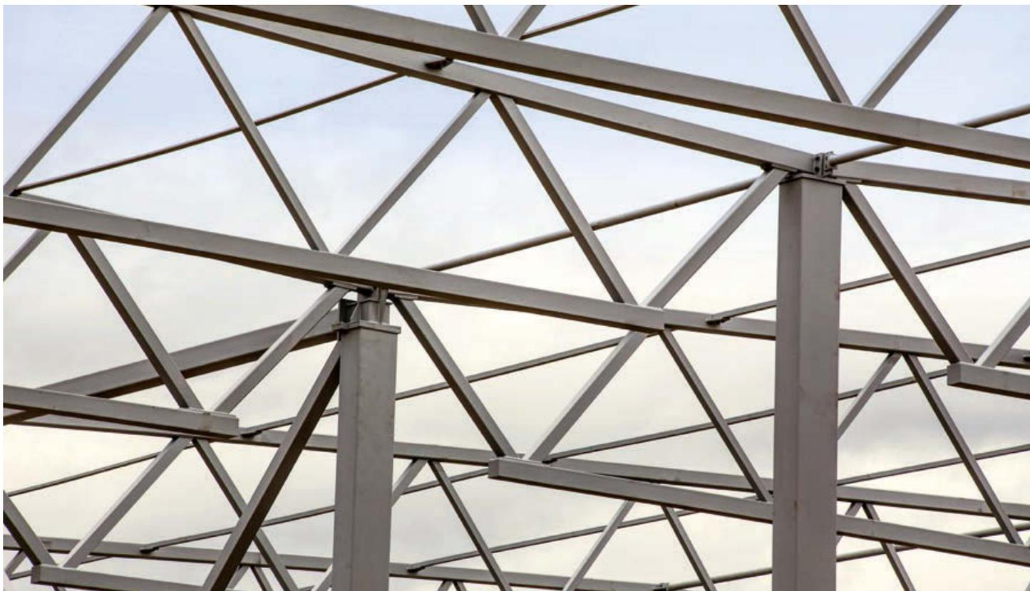
➤ PREON® box - weitgespannte Tragwerke aus MSH-Profilen
